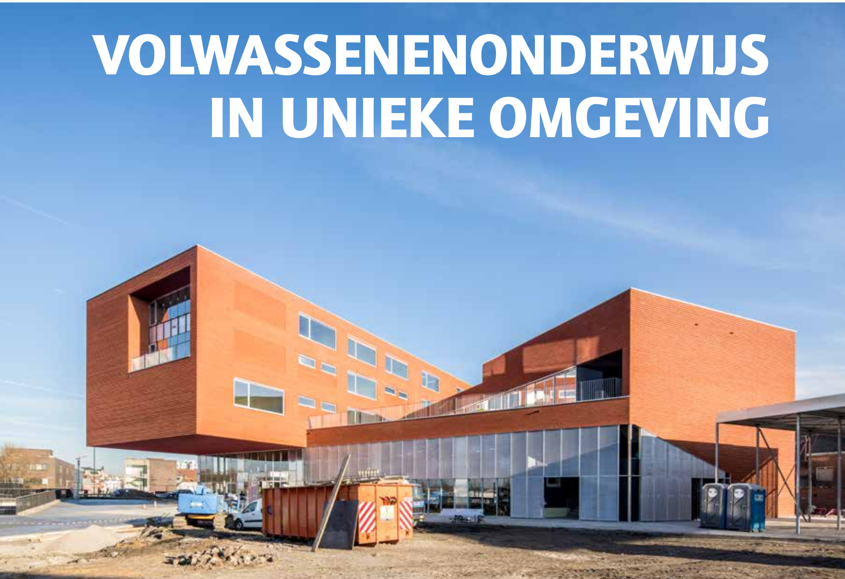
De grootste bouwtechnische uitdaging waren de drie bouwlagen met een uitkraging van tien meter. (Foto: Artitec)
